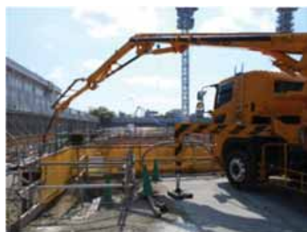
写真1 ポンプ車設置状況
