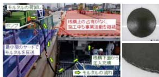
写真-1 施工状況例(左)および充填する超高強度モルタルのフロー試験状況(右)
