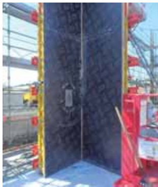
写真-1 システム型枠
