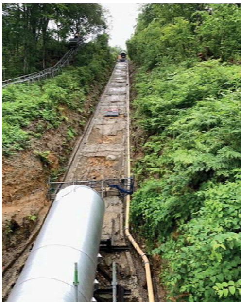
写真－9 型枠施工前の現場
