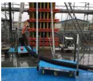
写真-2 圧入口接続状況
