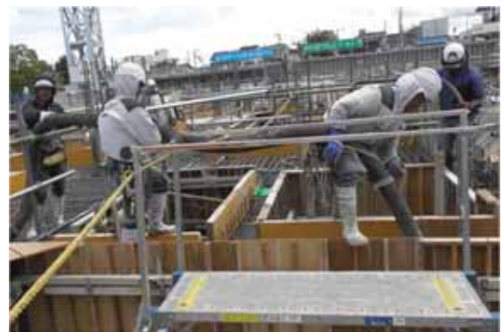
写真 6 配管圧送の場合の筒先作業状況
