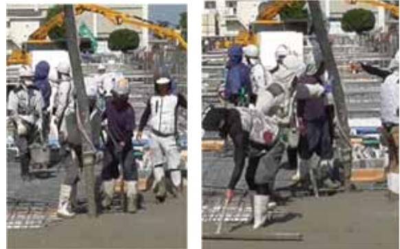
写真 4 ディストリビュータを用いた圧送作業状況
