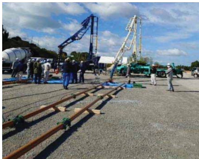
写真-2 2系列による圧送配管
