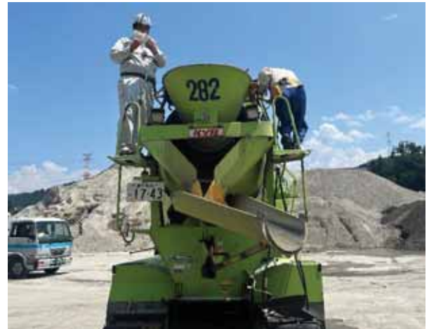
写真-1 ポンプ圧送助剤添加状況
