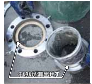
写真-6 打込み後の回転治具の状況
