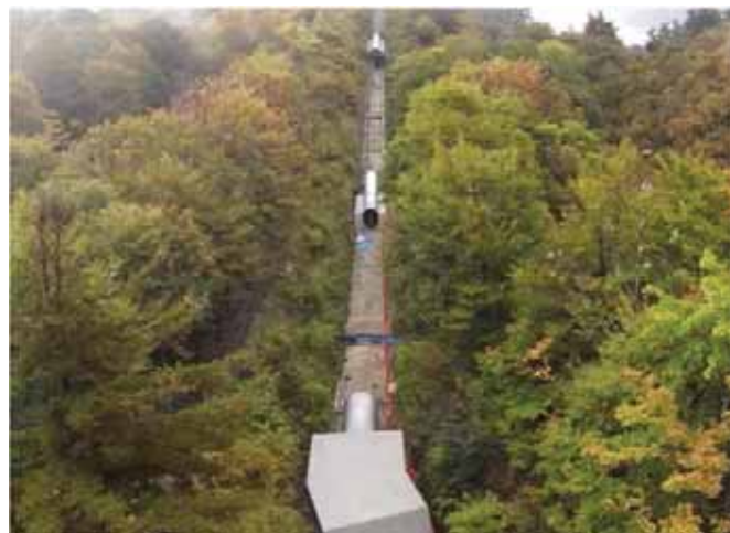
写真－10 打設完了後の現場遠景
