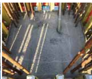
写真-3 締固め状況
