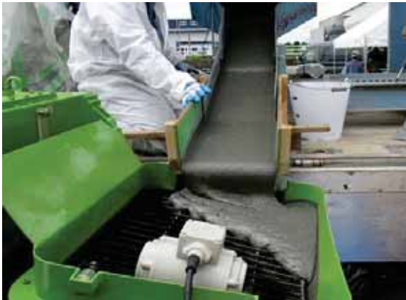
写真-1 モルタルの排出状況
