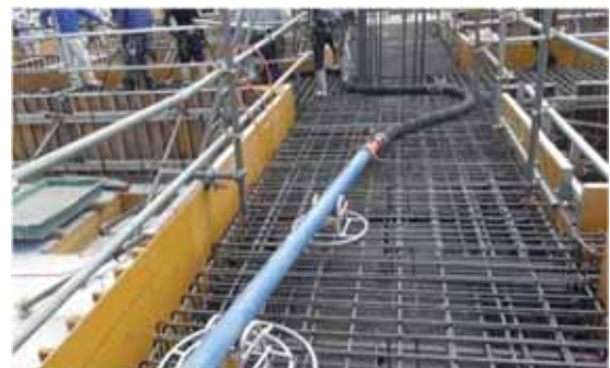
写真 7 配管圧送の場合の鉄筋上の様子
