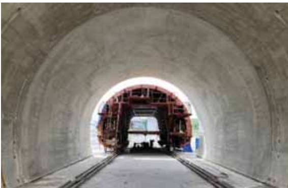
写真-2 覆工の出来映え (2 回目実験)
