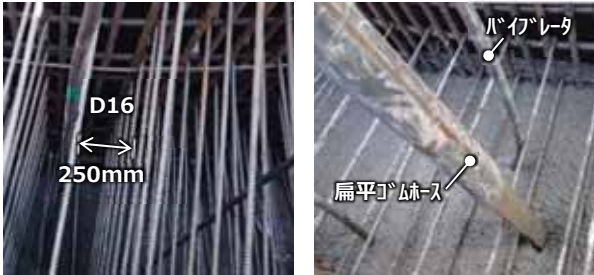
写真-4 配筋状況 (せん断補強筋)
