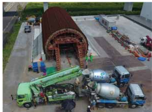
写真-1 実物大施工実験の実施状況
