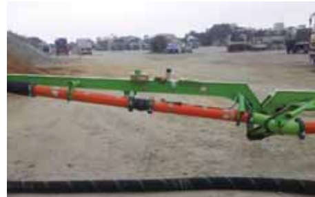
写真-3 圧力計の設置状況 (P4)
