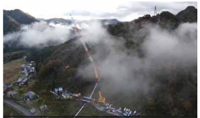
写真－1 現場全景
