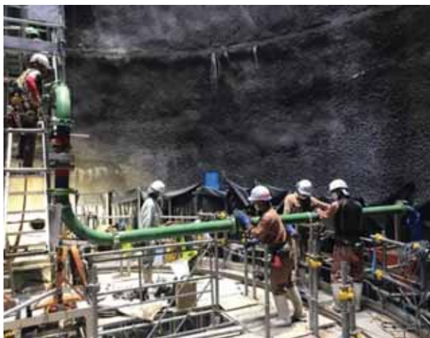
写真-13 壁コンクリートの打込み状況（近景）
