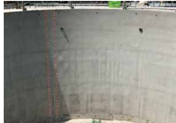
写真-7 コンクリート表面の仕上がり
