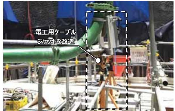
写真-10 軸受けの回転機構
