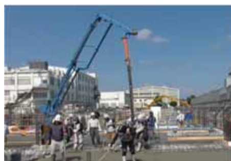
写真3 ディストリビュータを用いた施工状況
