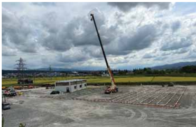
写真-2 長距離圧送試験配管全景
