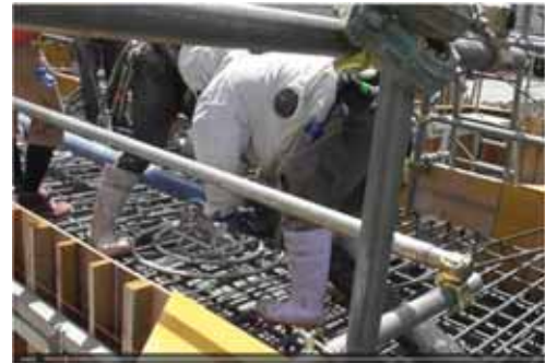
写真 5 従来の配管の段取り替え
