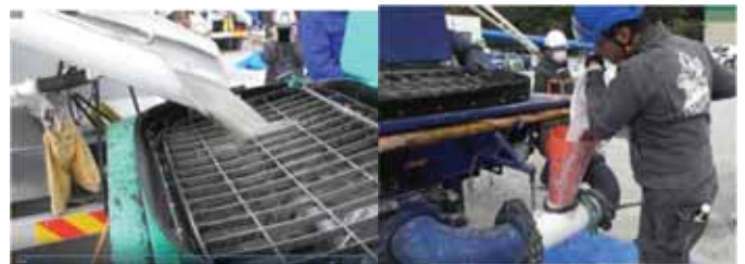
写真3 生コン車からホップ投入 写真4 先送り材のホップ投入
