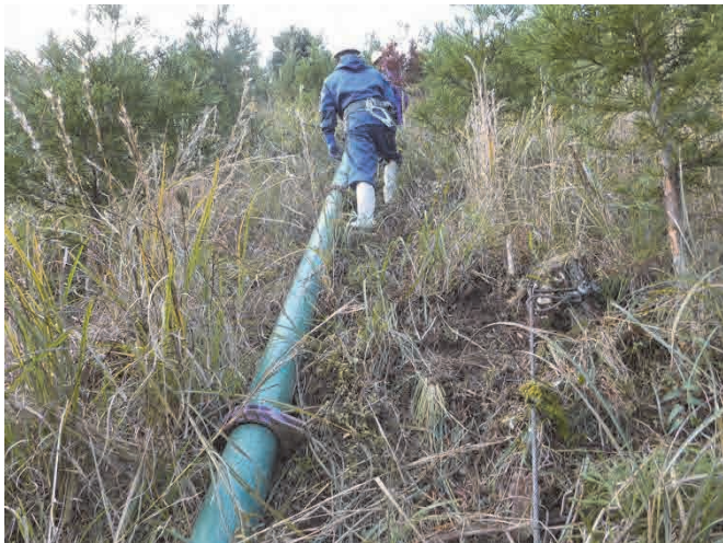
写真-2 山肌斜面への配管敷設作業の様子
