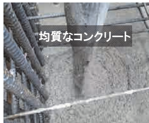
写真-7 かぶり部 付近の打込み状況
