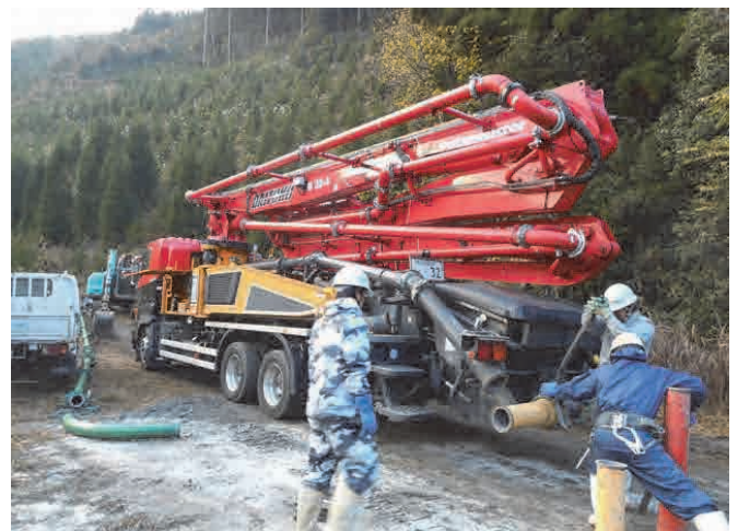
写真-1 使用したコンクリートポンプ車
