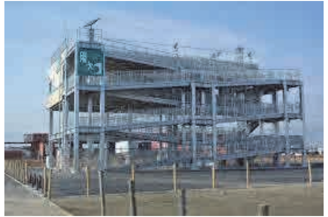
写真-10 仙台市・白鳥防災避難タワー
