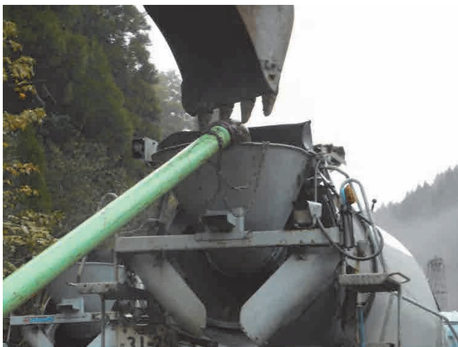
写真-11～写真-12 残コンクリートの返送の様子
