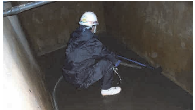
写真-6, 写真-7 汚泥の洗浄作業の様子
