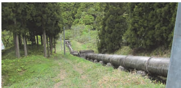
写真-1 現場状況
