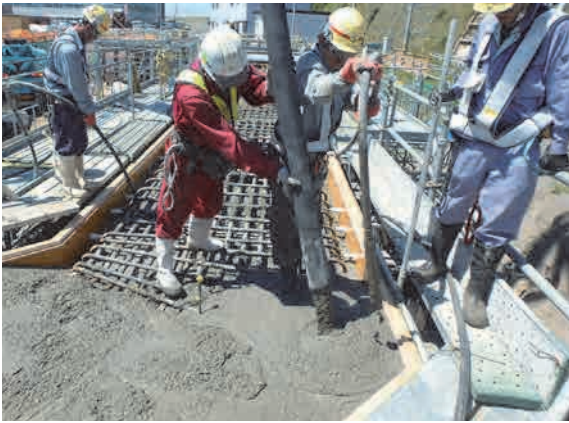
写真-5 吊るし打ちの状況②
