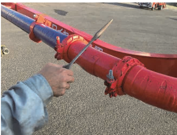
写真-1 打音検査
