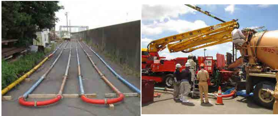
写真-1 ポンプ圧送実験の様子
