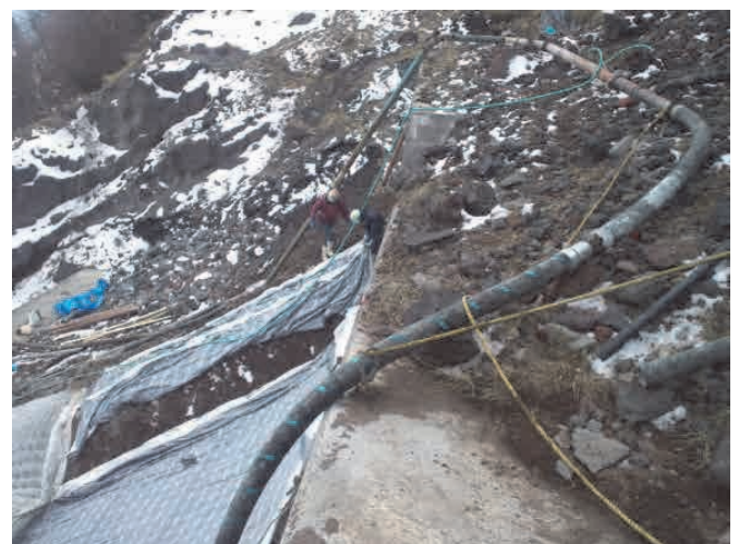
写真-2 輸送管の敷設状況
