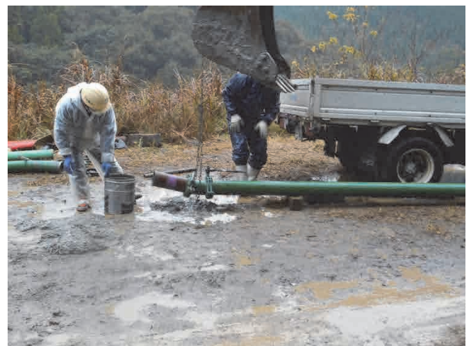
写真-10 返送用輸送管へのセメントペースト注入
