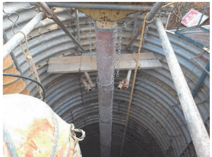
写真-3、写真-4 基礎第1層目への圧送の状況
