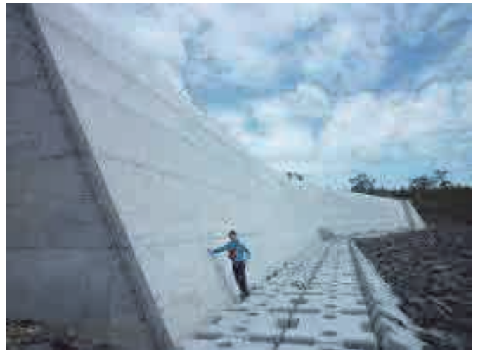
写真-11 仙台市荒浜港付近・吉田浜防潮堤
