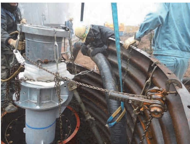
写真-6～写真-8 基礎第2層目への圧送の状況
