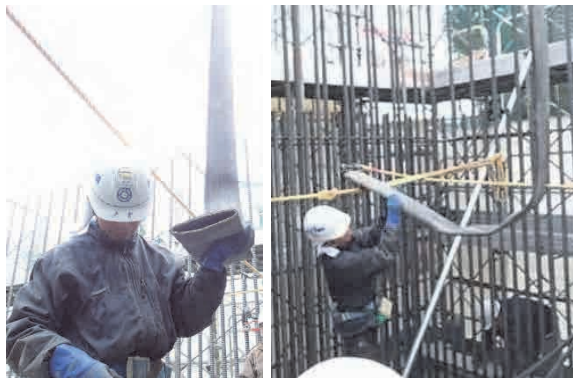
写真-8 扁平ホース移動時の状況
