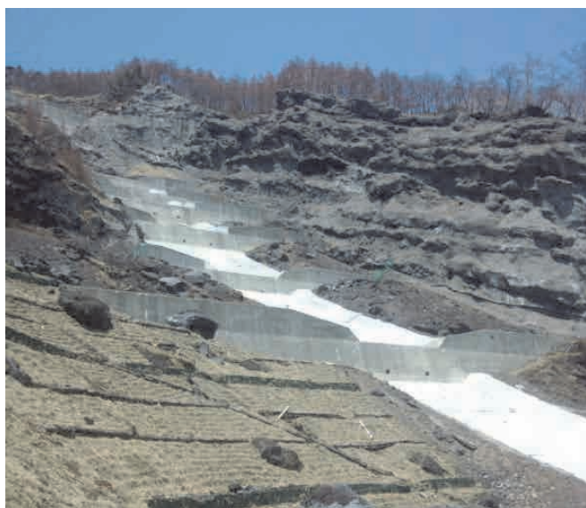
写真-3 打設現場の遠景
