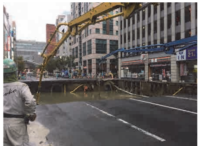
写真-1 流動化処理土の圧送作業の様子
