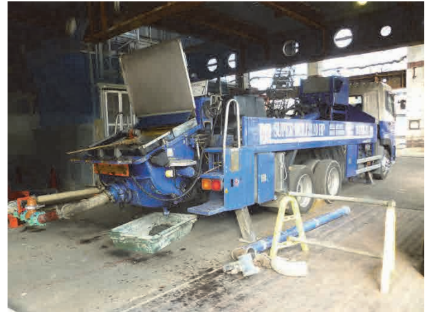
写真-3 圧入施工に用いたコンクリートポンプ
