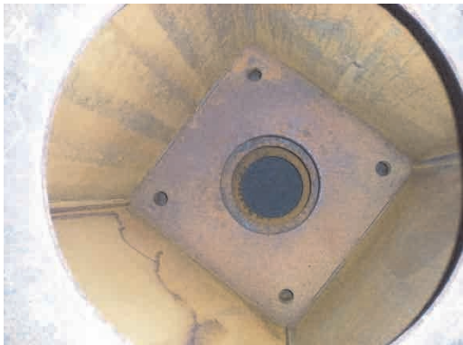
写真-1 鋼管柱の空気抜き孔
